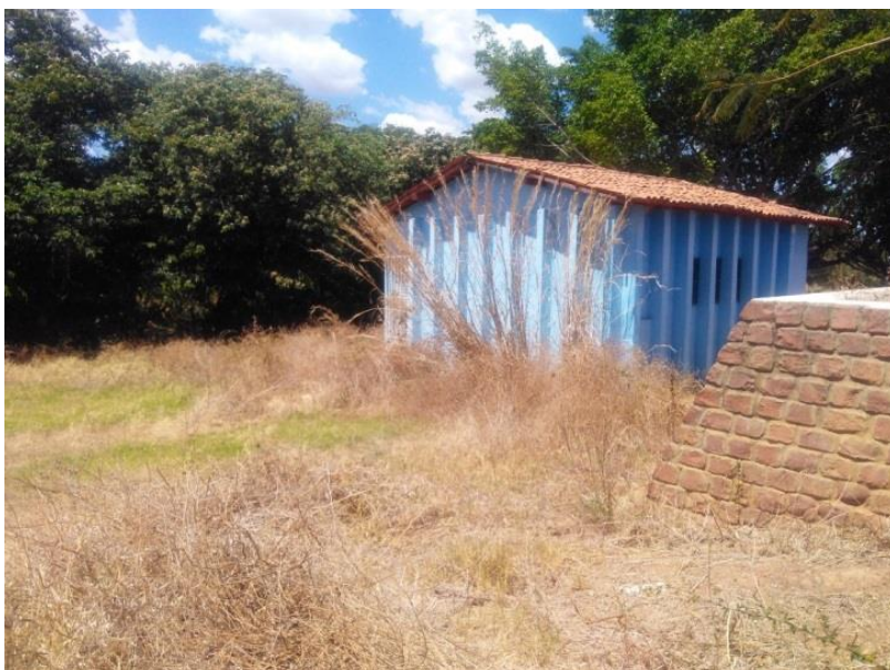
Figura 65. Sala verde desativada. FONTE: SEMATUR, 2020
