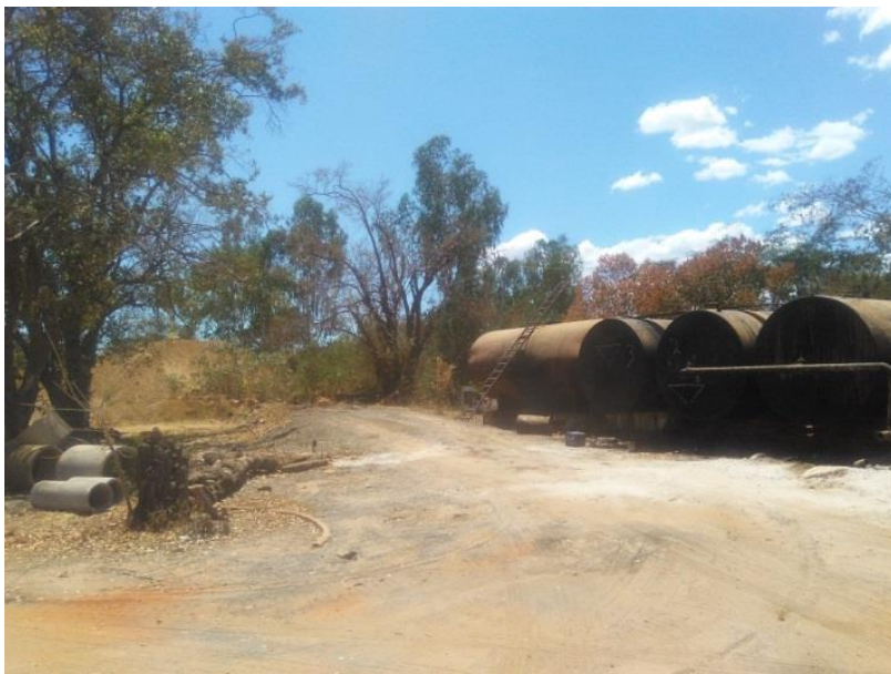
Figura 62. Usina de asfalto em APP. FONTE: SEMATUR, 2020
