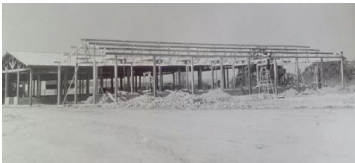
Figura 4. Área de exposição dos animais em fase de construção. FONTE: PITTA, Inês.
