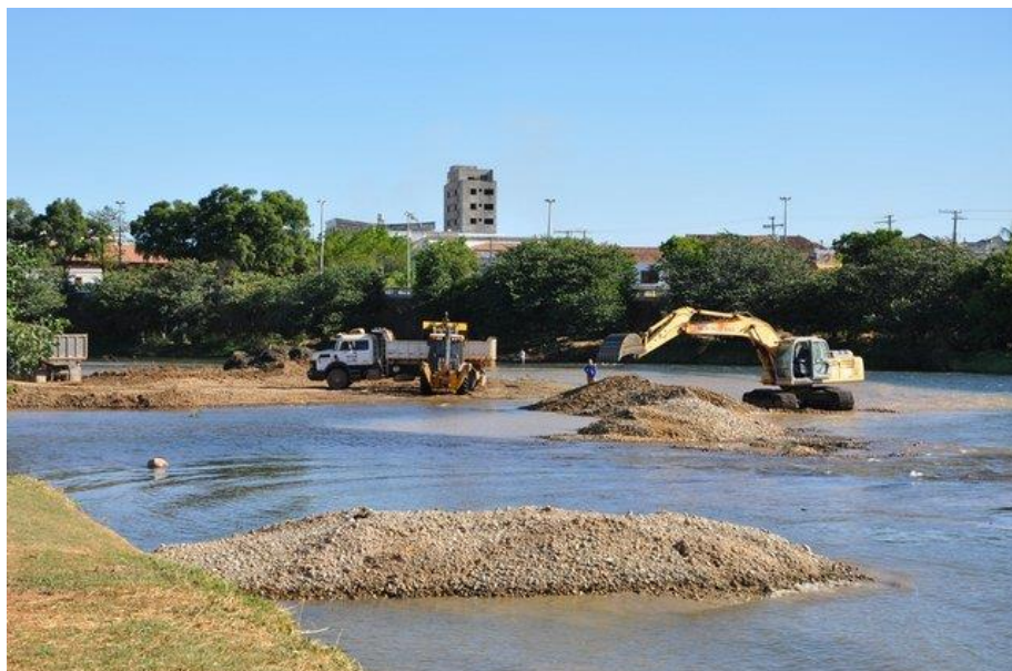
Figura 9. Retirada do material acumulado no leito do Rio Grande e às suas margens. FONTE: Barreiras, 2019.
